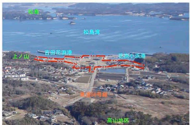
県道58号線上空より
