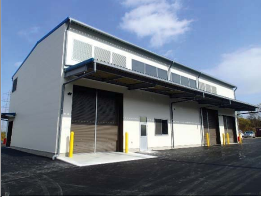
《共同乾燥調製施設整備》
