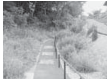
汐見台南二丁目防災避難路
