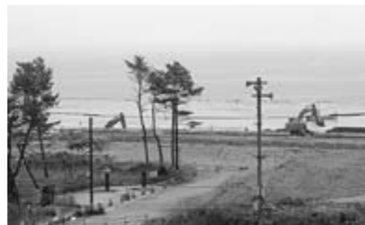
工事中の公園予定地
