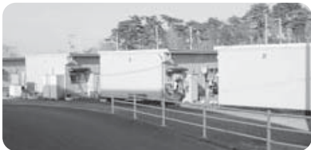
現在の仮設住宅 (七中第2グラウンド)
