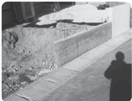
工事が進む高台住宅移転（代ヶ崎浜立花）
