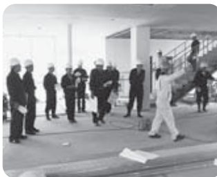
建築中の七ヶ浜中学校を視察
