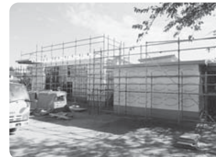
工事中の湊浜地区避難所
