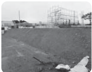
住宅建築が始まる高台住宅
