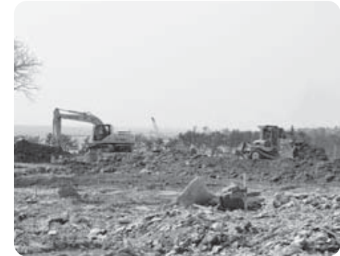
急ピッチで進めて欲しい造成工事
