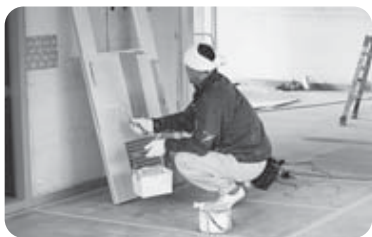
改修工事の子育て支援センター
