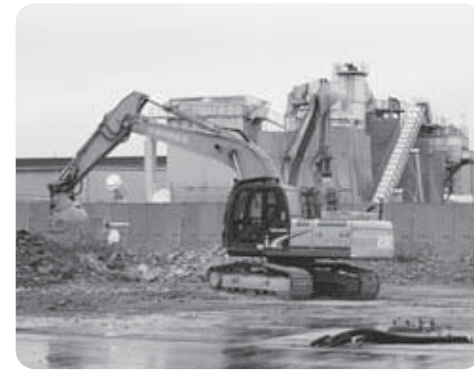
解体中の焼却設備（宮城東部JV）
