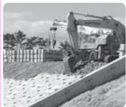
工事が進む防潮堤
