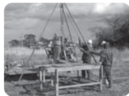
ボーリングによる調査 (林合地区)
