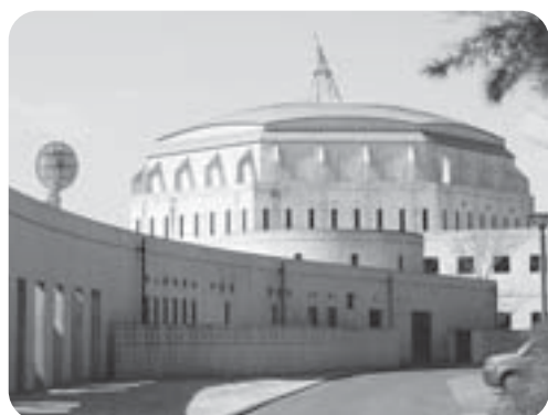
太陽光発電施設を設置 (国際村)
