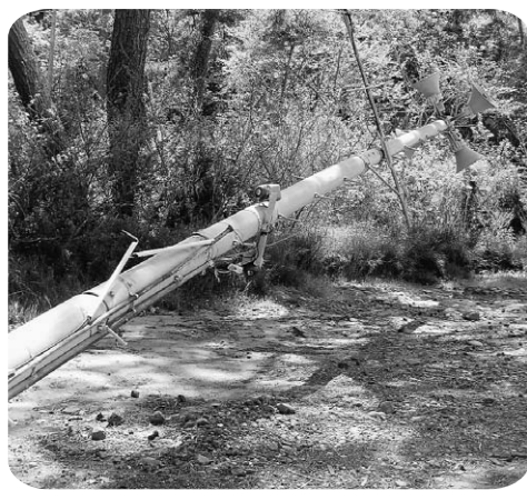
壊れた防災無線
