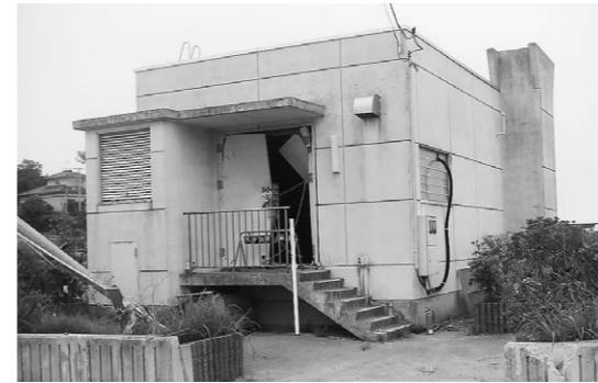
復旧が待たれるポンプ場(松ヶ浜)
