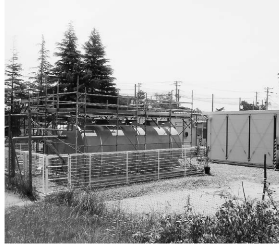
七ヶ浜中第2グラウンドの浄化槽
