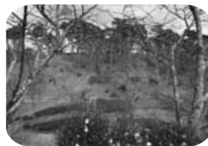
撤去作業が進んでいる君ヶ岡公園
