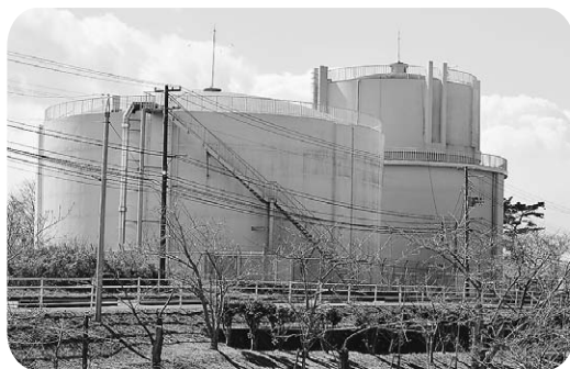
君ヶ岡配水池
