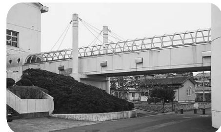
向洋中学校空中回路（渡り廊下）
