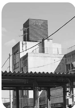
汐見小の高架水槽
