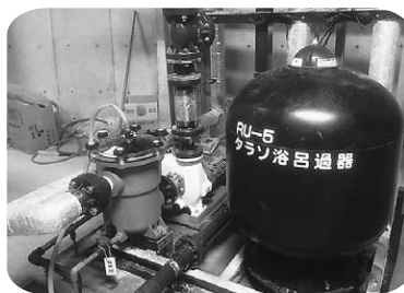
改修するろ過機タンク
