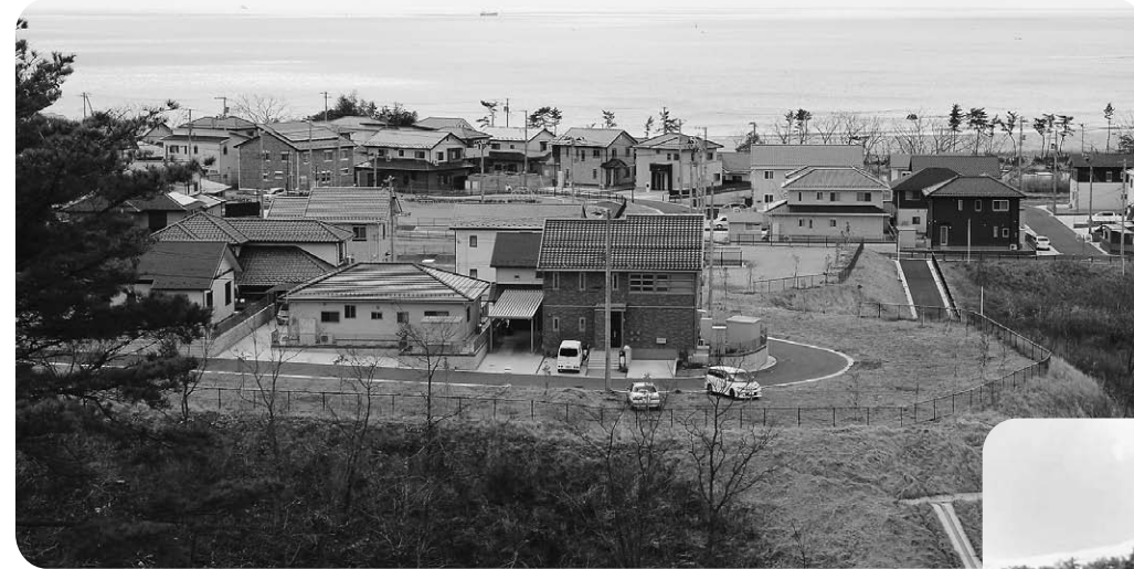
山を崩して住宅団地（笹山地区）
