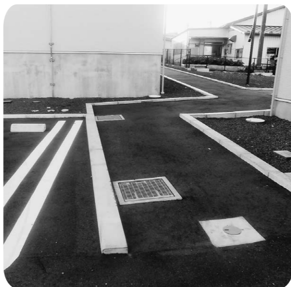
駐車場から上り傾斜の公営住宅
