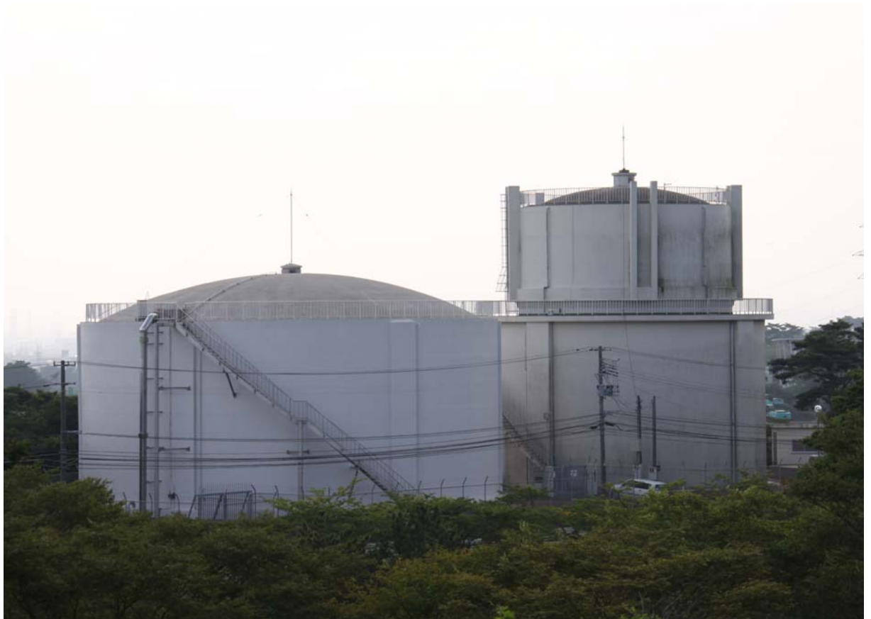
君ヶ岡配水池
