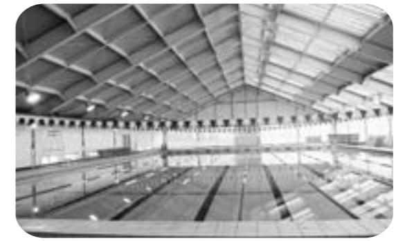
より良い点検・清掃が必要なプール
