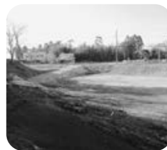
解体された亦小プール跡地
