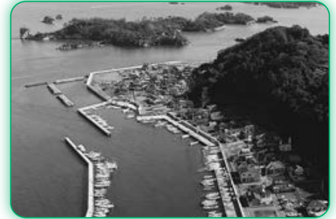
代ヶ崎浜地区広場・長須賀多目的広場
