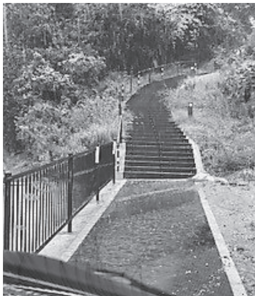
下から撮影したS字避難階段
