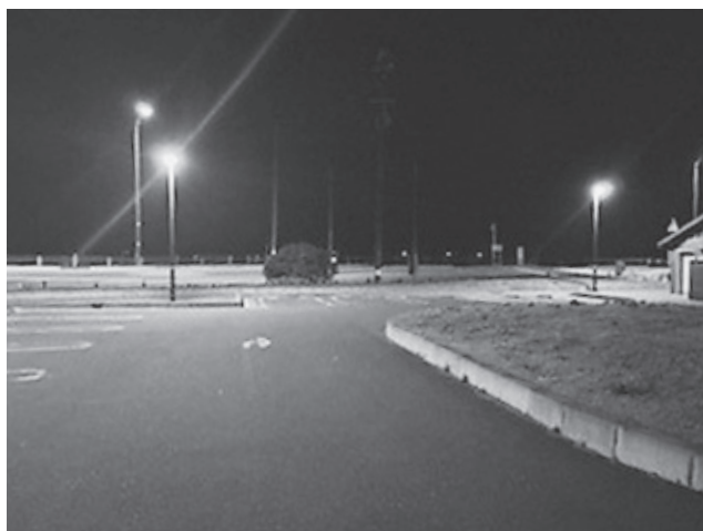
小豆浜駐車場の夜間照明状態
