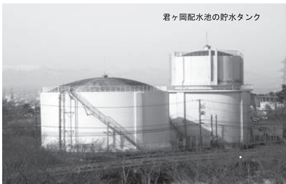
2021年の5000 3 mタンクの改修では、 タンクの内面にステンレスを張り強化
