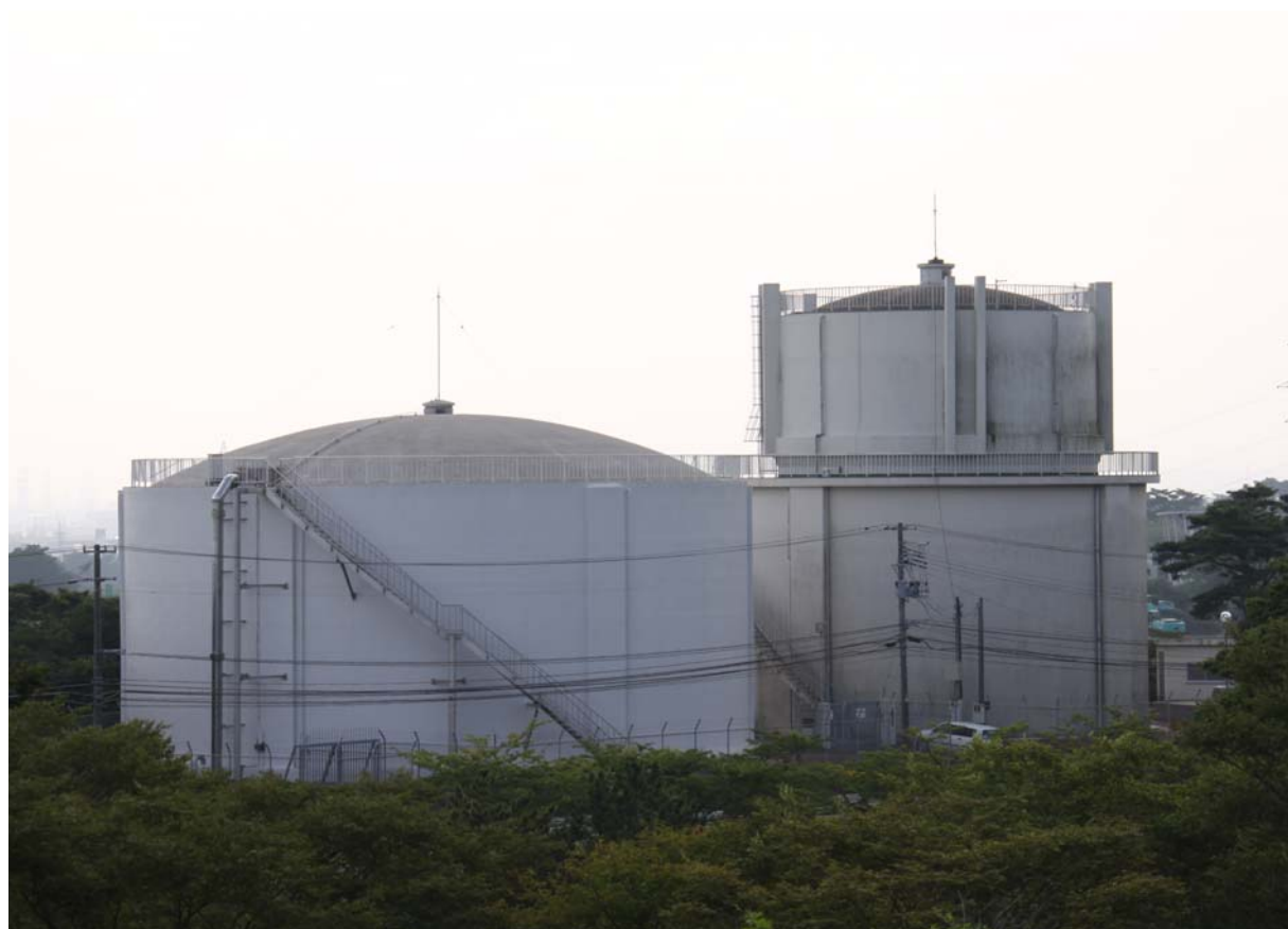
君ヶ岡配水池
