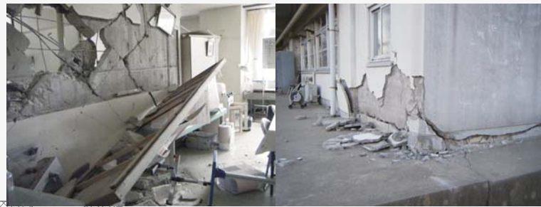
□七ヶ浜中学校の被災状況
