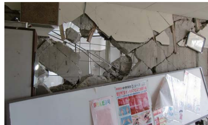
全壊した七ヶ浜中学校
