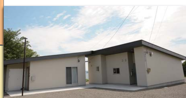
④ 災害公営住宅整備事業 吉田浜地区
