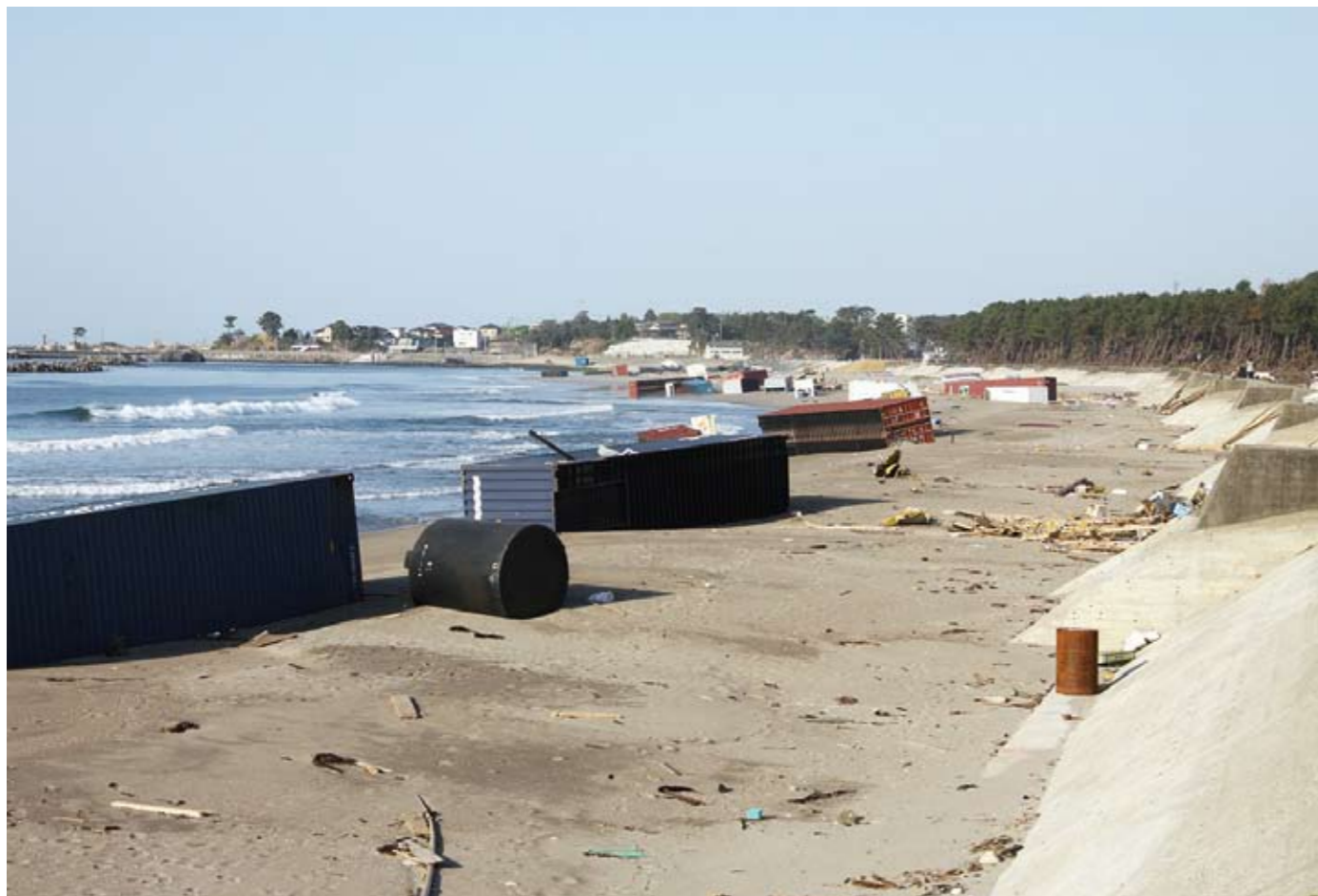
被災直後、菖蒲田海水浴場には、仙台塩釜港仙台港区などから流されたコンテナやガレキが散乱した。(平成23年5月15日撮影)
