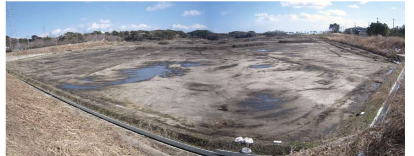
ガレキが散乱する震災直後の東宮浜字新下田の農地。災害ボランティアの力を借りながら、復旧が進められた。(上が被災直後、下が復旧作業後)
