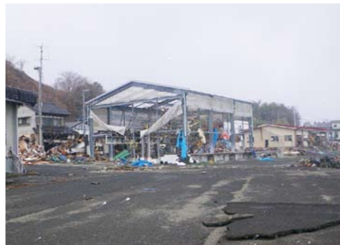
被災後の大型陸上採苗機(平成23年3月17日撮影)
