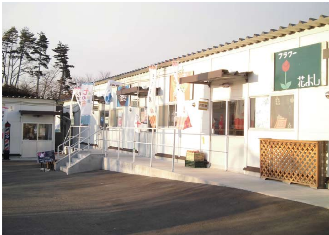
生涯学習センター入口に設置された仮設商店街
