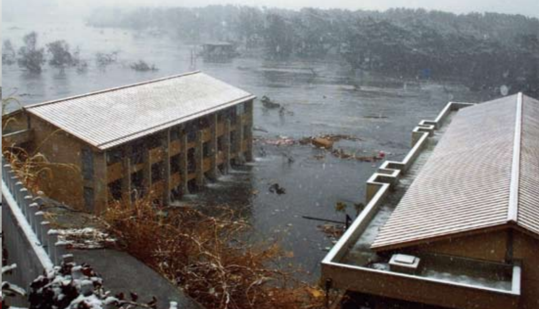
汐見台南2丁目町営住宅付近
