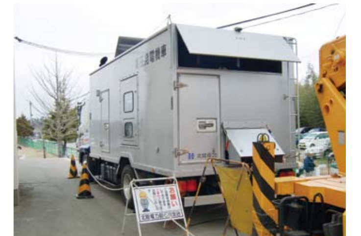
電力を供給する北陸電力の高圧発電機車
