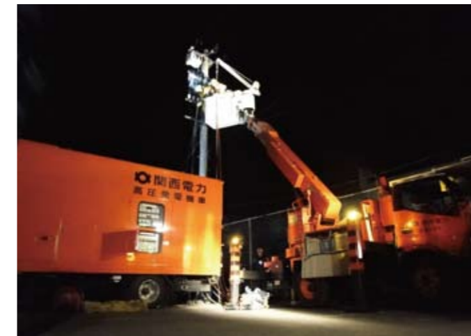
電力供給へ向けて作業を進める関西電力の作業員
