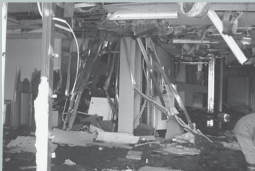
(震災により被災した発電所内)
