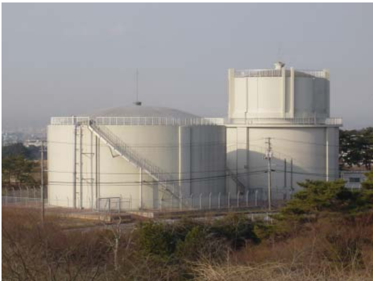
君ヶ岡配水池
