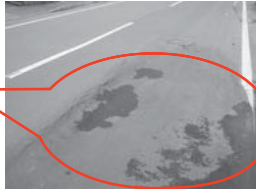
松ヶ浜謡線 道路陥没
