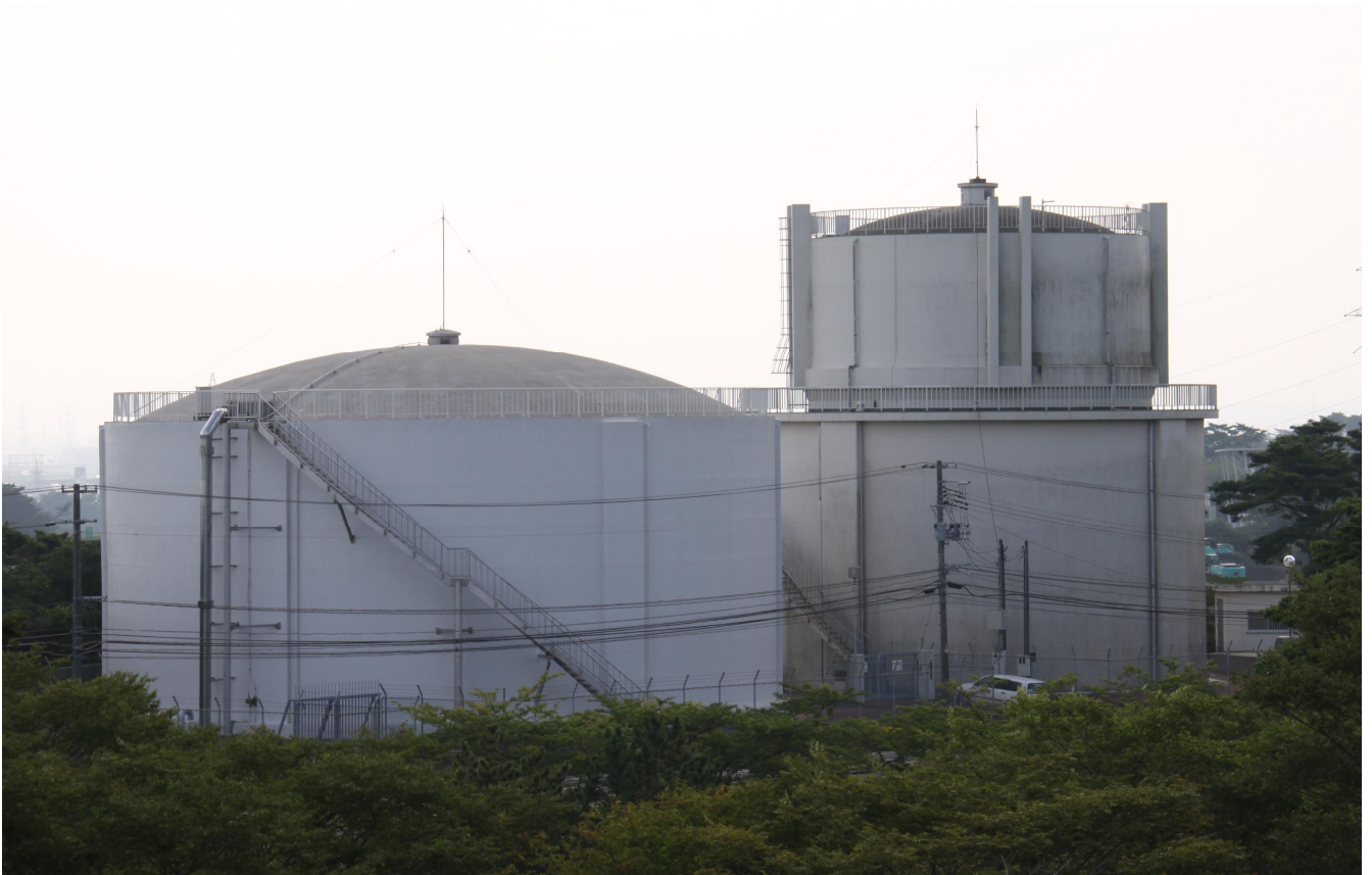
君ヶ岡配水池
